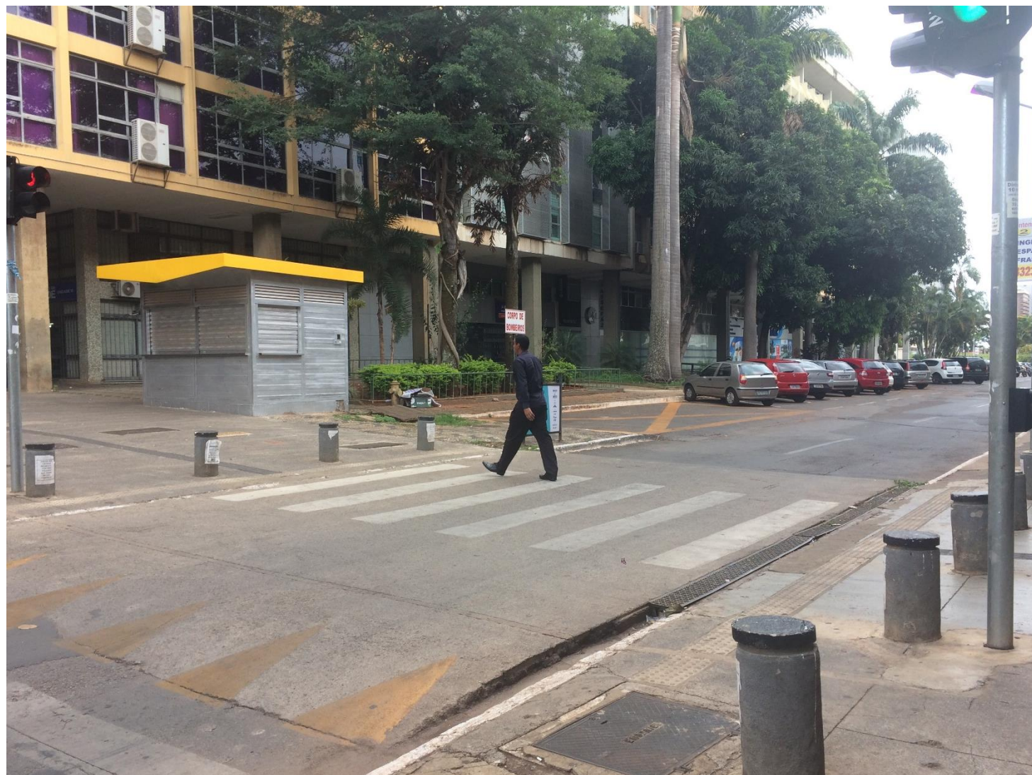
Travessia elevada de pedestres no Setor Comercial Sul – Plano Piloto.
