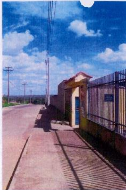
Foto 03 – Vista frontal do lote – área pública Voltada para a Rua G do Setor de Indústrias
