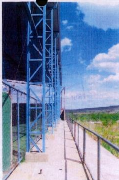
Foto 02 – Vista de fundos do lote O alambrado baixo estabelece o limite do lote
