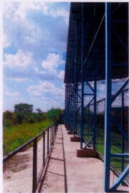
Foto 01 – Vista de fundos do lote O alambrado baixo estabelece o limite do lote
