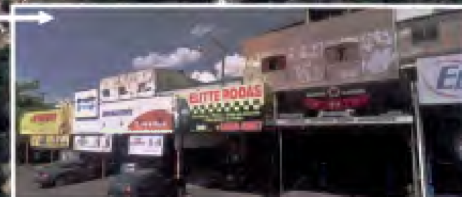
cobertura com obstrução parcial
