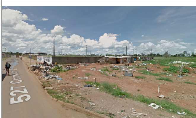
Figura 16 - Ao lado da ÁREA do PEV há uma garagem de ônibus irregular em desconformidade com o projeto de urbanismo.
