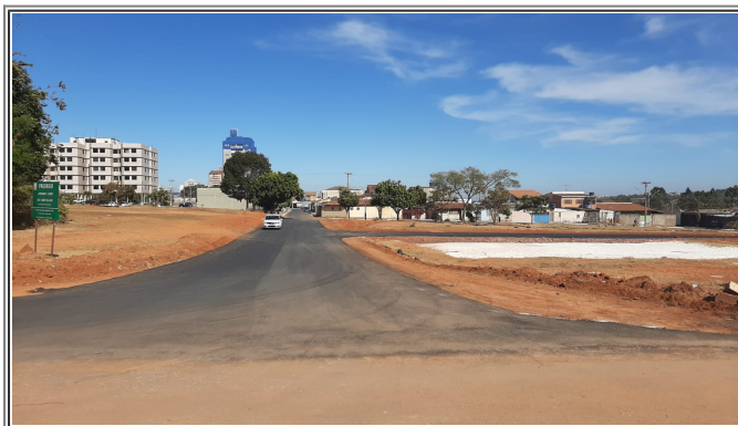
Figura 10 - Acesso viário executado sem diretriz de projeto e sem SIV aprovado.
