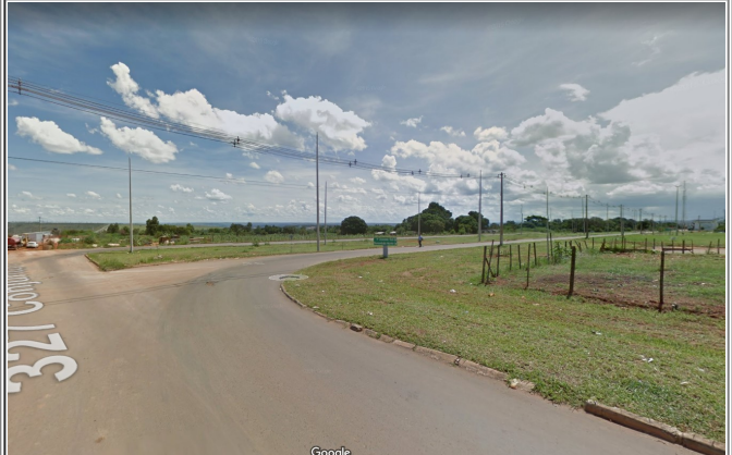
Figura 17 - Área localizada a frente do PEV com sistema viário oficial.
