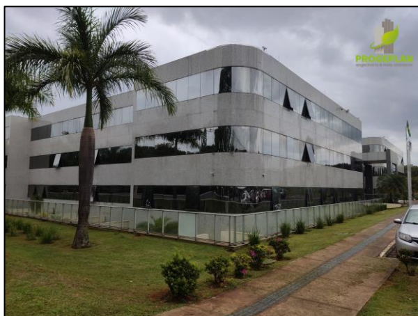
Foto 3.1: Prédio instalado na área de estudo e que será alvo de ampliação da área útil.
