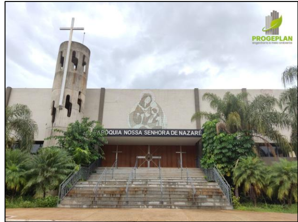
Foto 4.2: Paróquia Nossa Senhora de Nazaré localizada ao lado da edificação em estudo, na AID do empreendimento.
