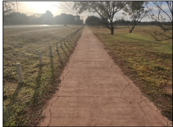
Foto 4.13: Ciclovia destinada aos ciclistas que percorre desde o início da EPDB a chega até o empreendimento.
