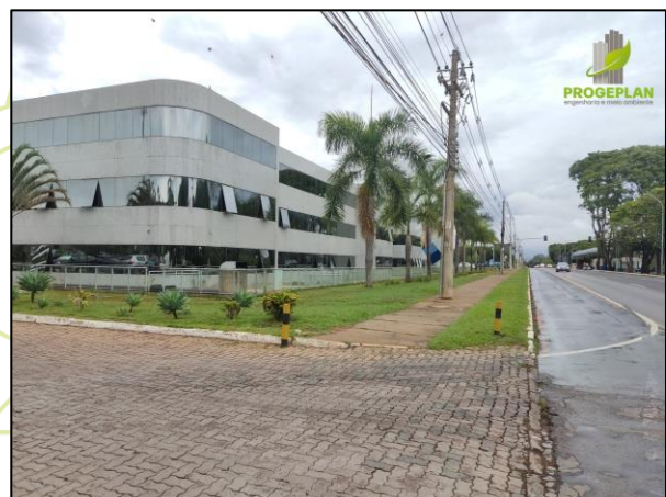
Foto 3.8: Vista do pedestre a partir da calçada na via de acesso ao empreendimento.
