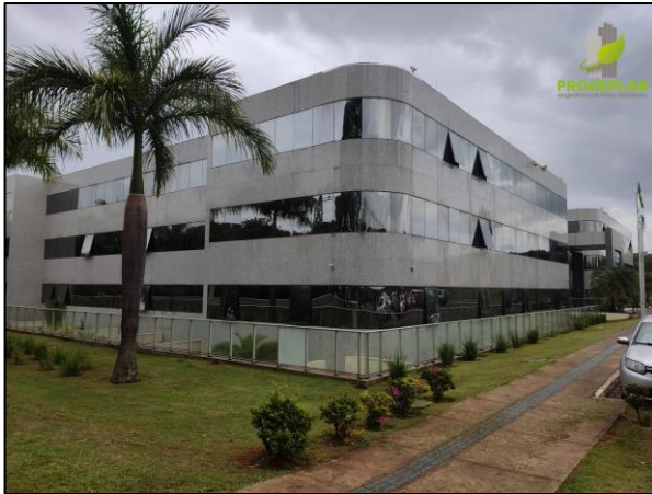
Foto 3.3: Vista do pedestre a partir da calçada na via de acesso ao empreendimento.
