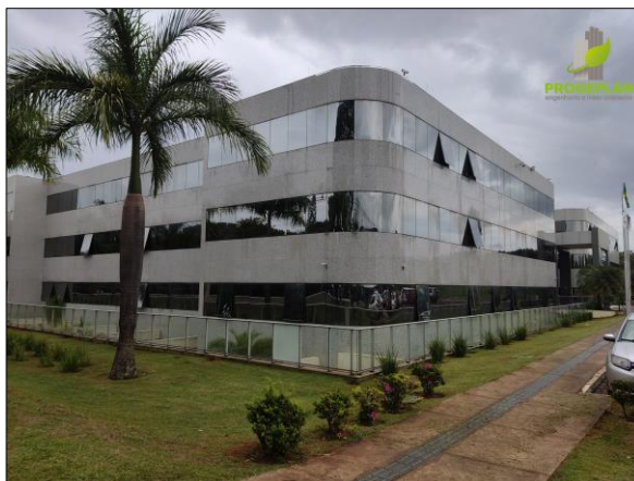
Foto 4.9: Fachada do empreendimento.
