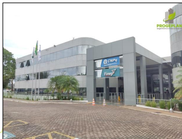
Foto 3.2: Prédio instalado na área de estudo e que será alvo de ampliação da área útil.
