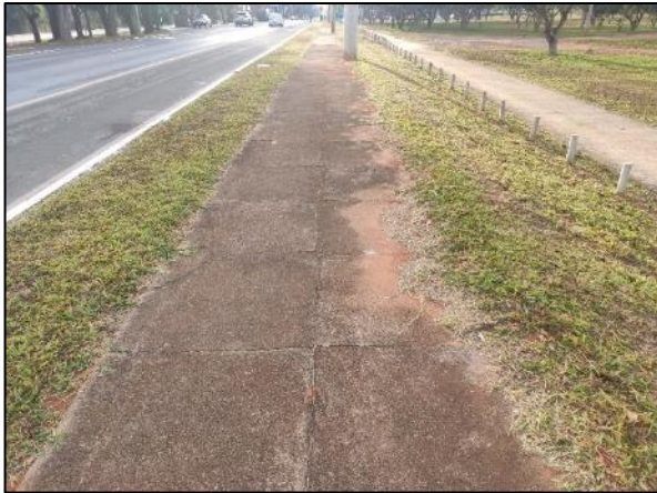
Foto 4.15: Calçadas ao longo da EPDB sentido leste com 1,9 metros de largura destinada à circulação de pedestres entre a ciclofaixa e a ciclovia.
