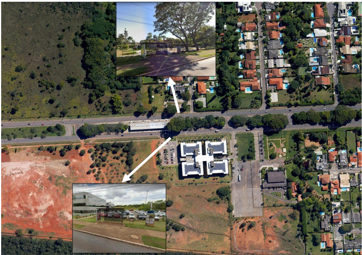
Foto 4.22: Localização em planta das paradas de ônibus próximas ao empreendimento.
