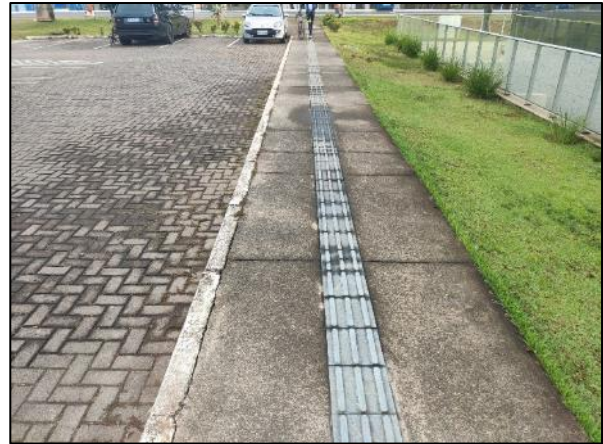
Foto 4.16: Passeio em frente ao empreendimento com pisos podotáteis, medindo 1,5 metros de largura, destinada à circulação de pedestres e orientação de pedestres com deficiência visual.
