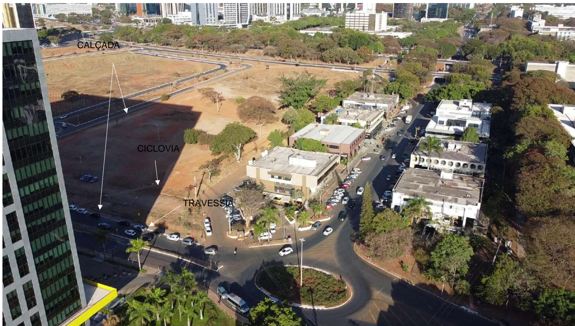
Figura 250 - Infraestrutura de pedestres e ciclistas nas proximidades do empreendimento.
