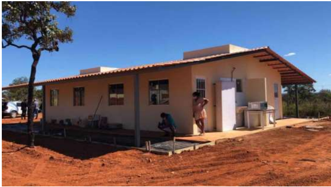
Figura 80 – Moradias provisórias cedidas pela Terracap.
