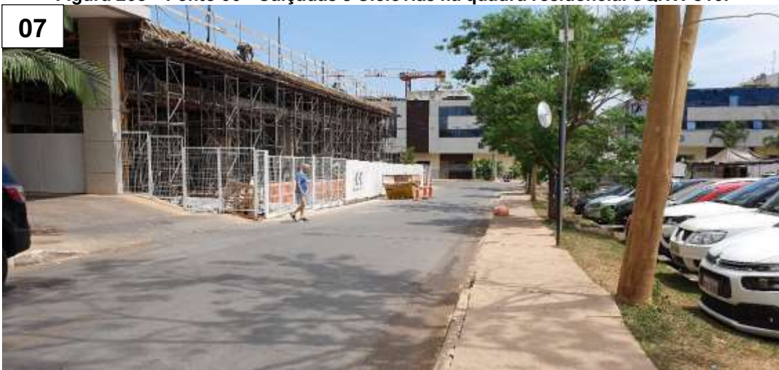
Figura 204 – Ponto 07 - Trechos em construção na CRNW 510.
