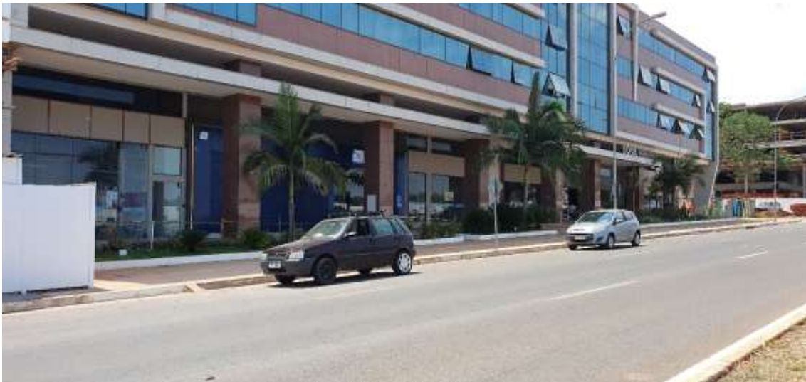
Figura 239 – Calçada sem rampas de acesso no lote em frente ao empreendimento.
