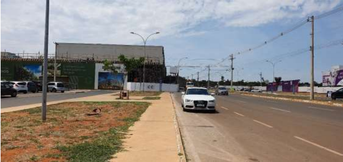
Figura 240 – Área prevista para implantação de parada com calçadas, porém sem rampas de acesso.
