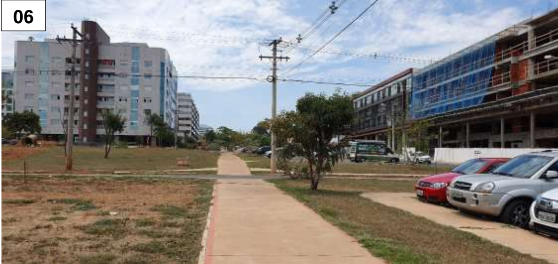
Figura 202 – Ponto 06 - Calçadas e Ciclovias na quadra residencial SQNW 310.
