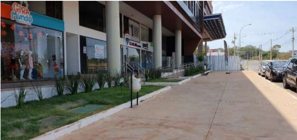
Figura 73 – Lixeiras no lote em frente ao empreendimento.
