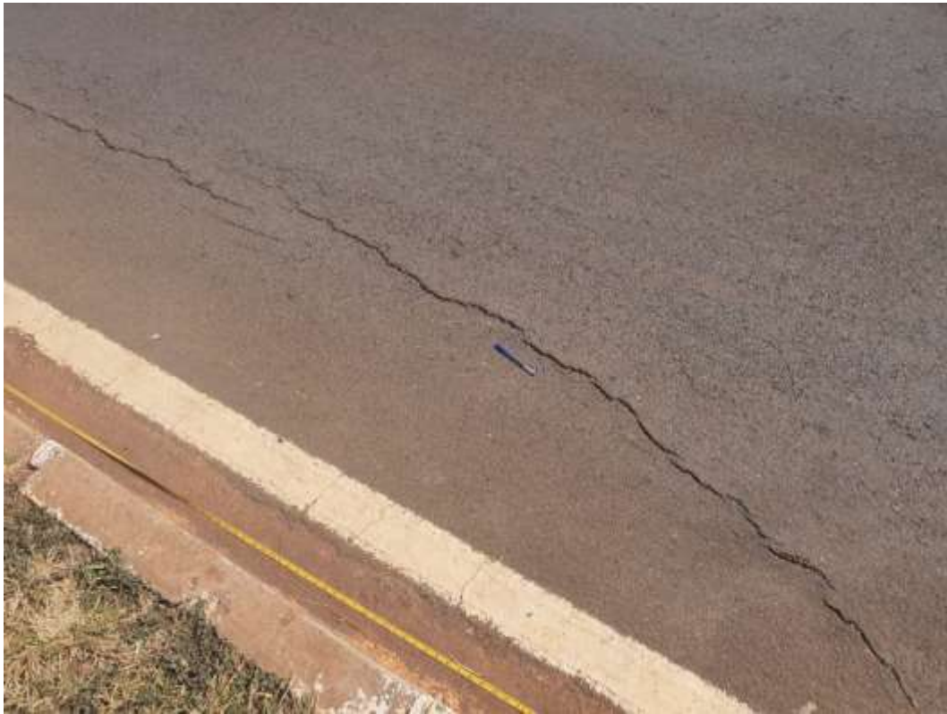
Figura 250 – Trinca Longitudinal.
