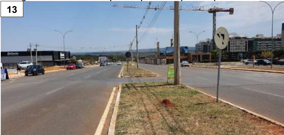
Figura 212 – Ponto 13 - Baías de ônibus demarcadas por pintura horizontal na via W9.
