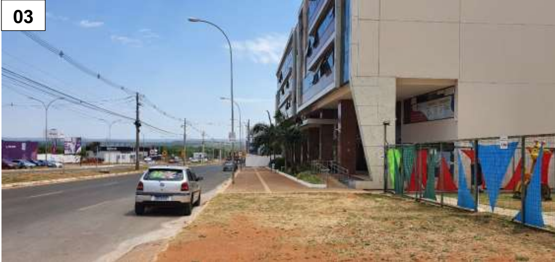
Figura 199 – Ponto 03 - Trechos com e sem calçada, sem rampas de acessibilidade na CRNW 510 – área em frente ao empreendimento.
