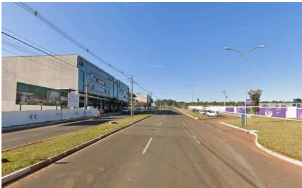
Figura 114 – Via W9. Fonte: Google Street View.
