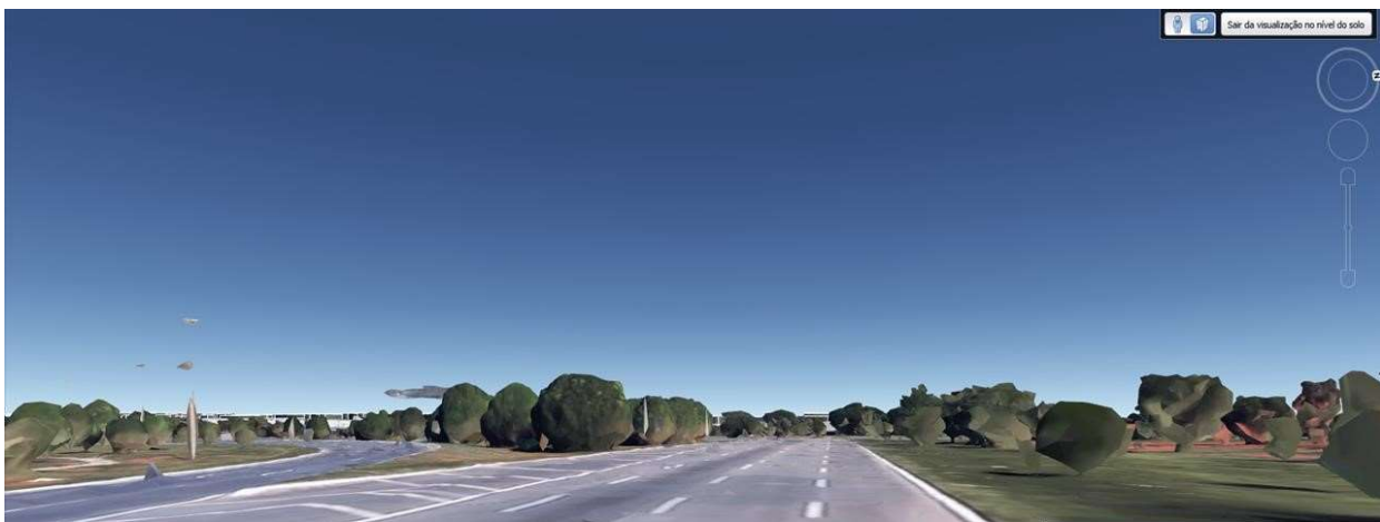
Figura 46 - Vista Eixo Monumental
