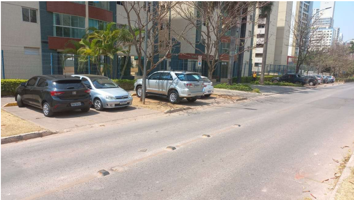
Figura 22: Estacionamento em frente a Q 105 PRAÇA BEM-TE-VI LT 2 para ser regularizado e qualificado
