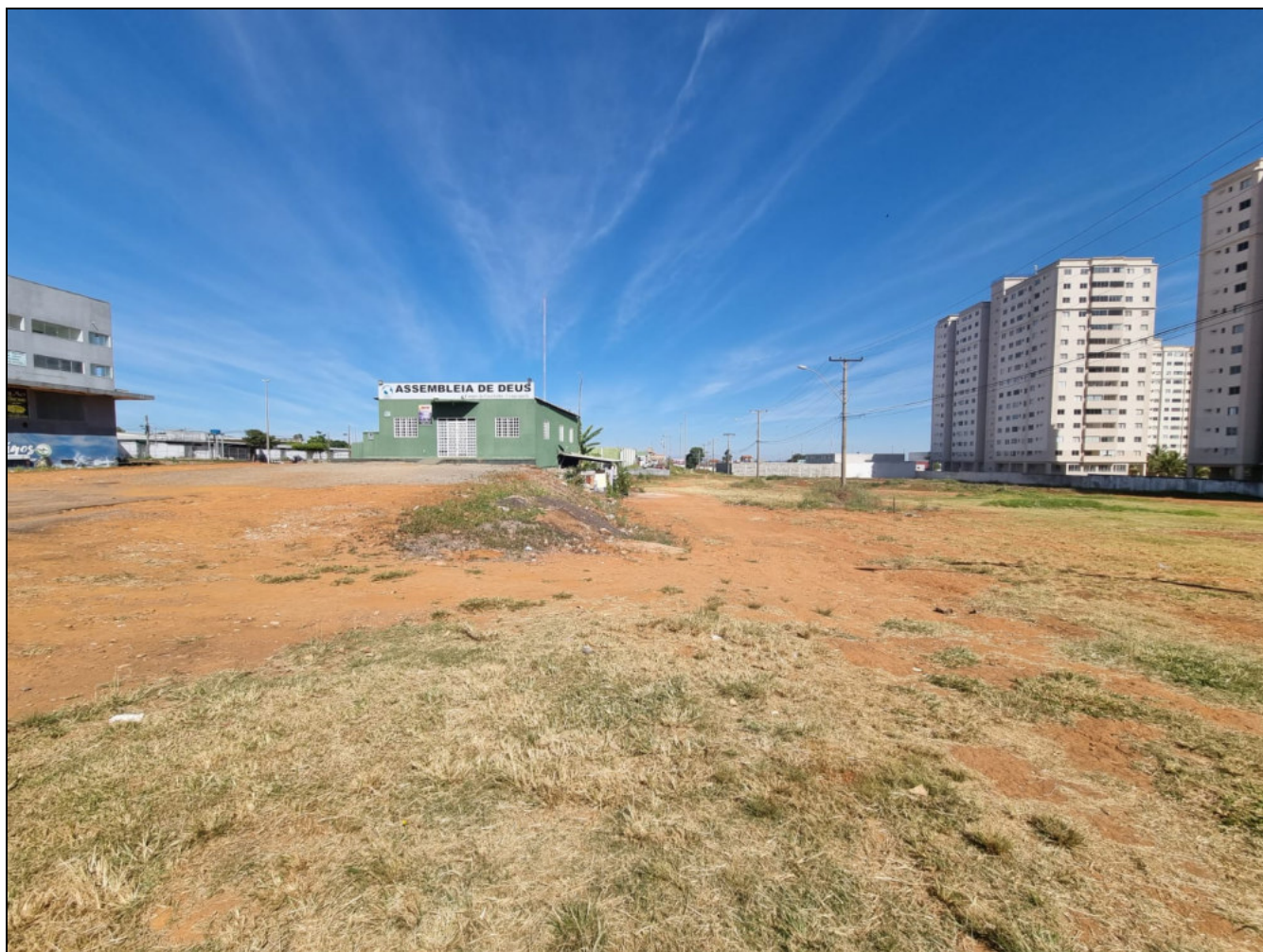
Figura 18- Área pública com Sistema viário previsto em projeto mas sem execução.
