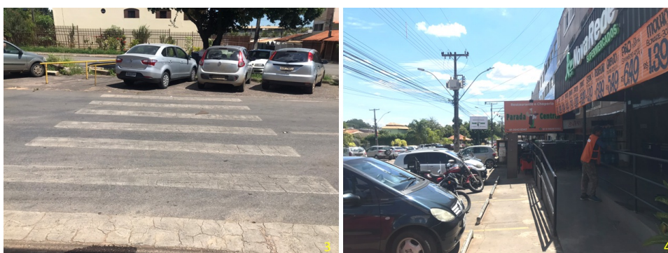
Figura 23 - Foto 3, passagem interrompida. Foto 4, total ocupação da calçada por comércio.
