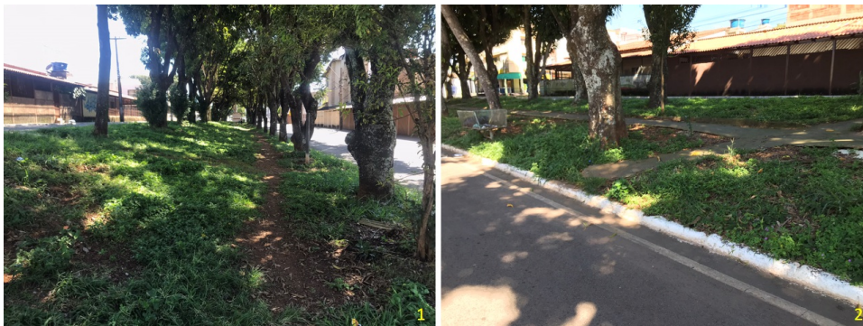
Figura 14 - Foto 1, descontinuidade da calçada no canteiro central. Foto 2, calçada em canteiro central sem acessibilidade.
