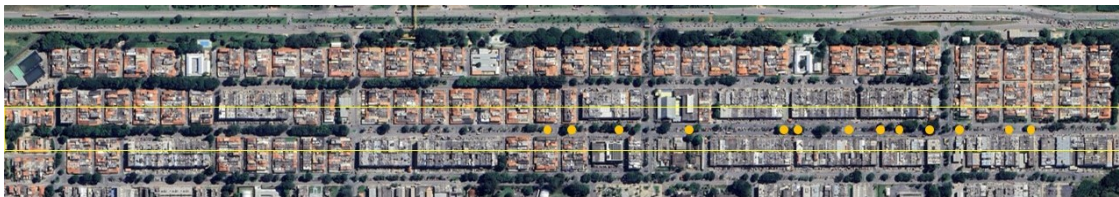
Figura 12 - Identificação dos quiosques regularizados, segundo indicação da Administração Regional do Núcleo Bandeirante. Fonte: doc. SEI nº 123803777
