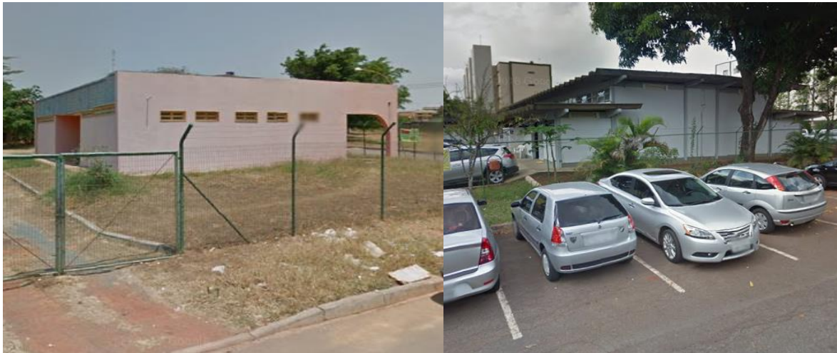
Figura 61. Relação de edifícios de Equipamentos Públicos com o espaço público. Esquerda: Unidade Básica de Saúde (UBS) Areal, Arniqueiras. Direita: Centro de Saúde (CS) 09, Cruzeiro.
