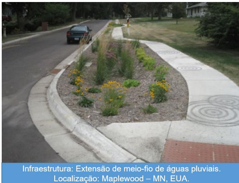
Figura 79: Exemplo de infraestrutura verde de drenagem urbana para Vias de Circulação de Vizinhança, Vias Parque e vias locais Fonte: Green Streets Handbook , 2021.
