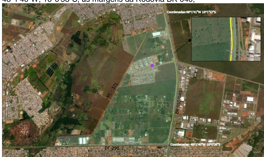
Figura 1 - Ilustra faixa de servidão com 10 metros de largura total, devido a implantação da Adutora de Água Tratada, denominada Adutora Corumbá , compreendida nas coordenadas aproximadas 48°1'41"W; 16°1'53"S e 48°1'40"W; 16°0'38"S, às margens da Rodovia BR 040;
