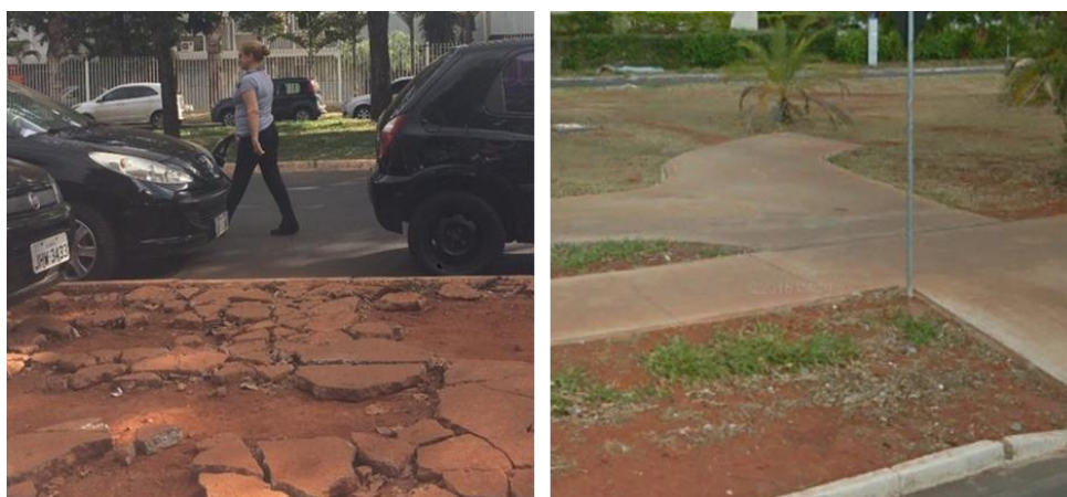
Figura 59: Esquerda: calçada em péssimo estado de conservação no SRTVS, Brasília. Direita: ciclovia descontinuada, Sudoeste.
