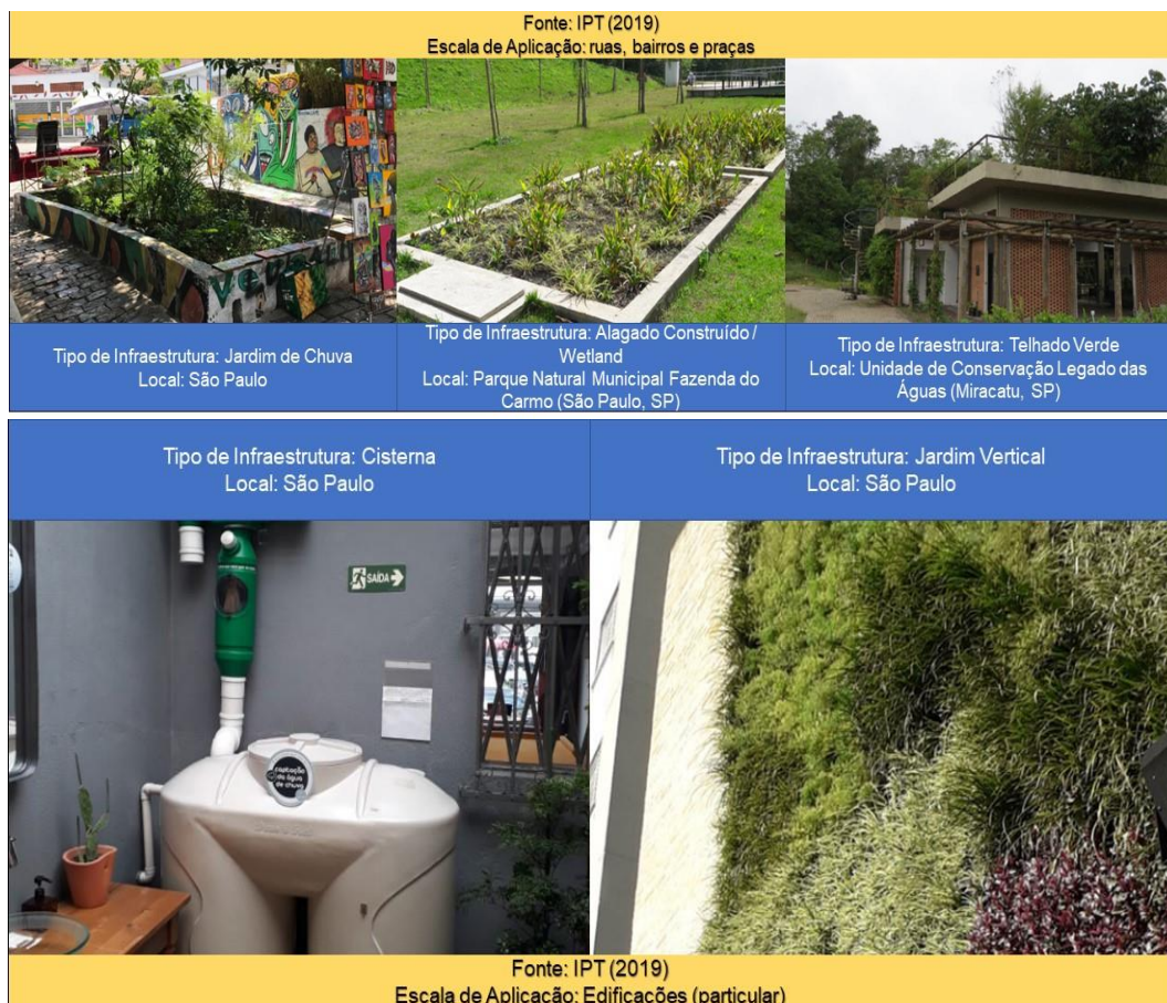
Figura 70: Exemplo de infraestrutura verde de drenagem urbana na escala da fonte
