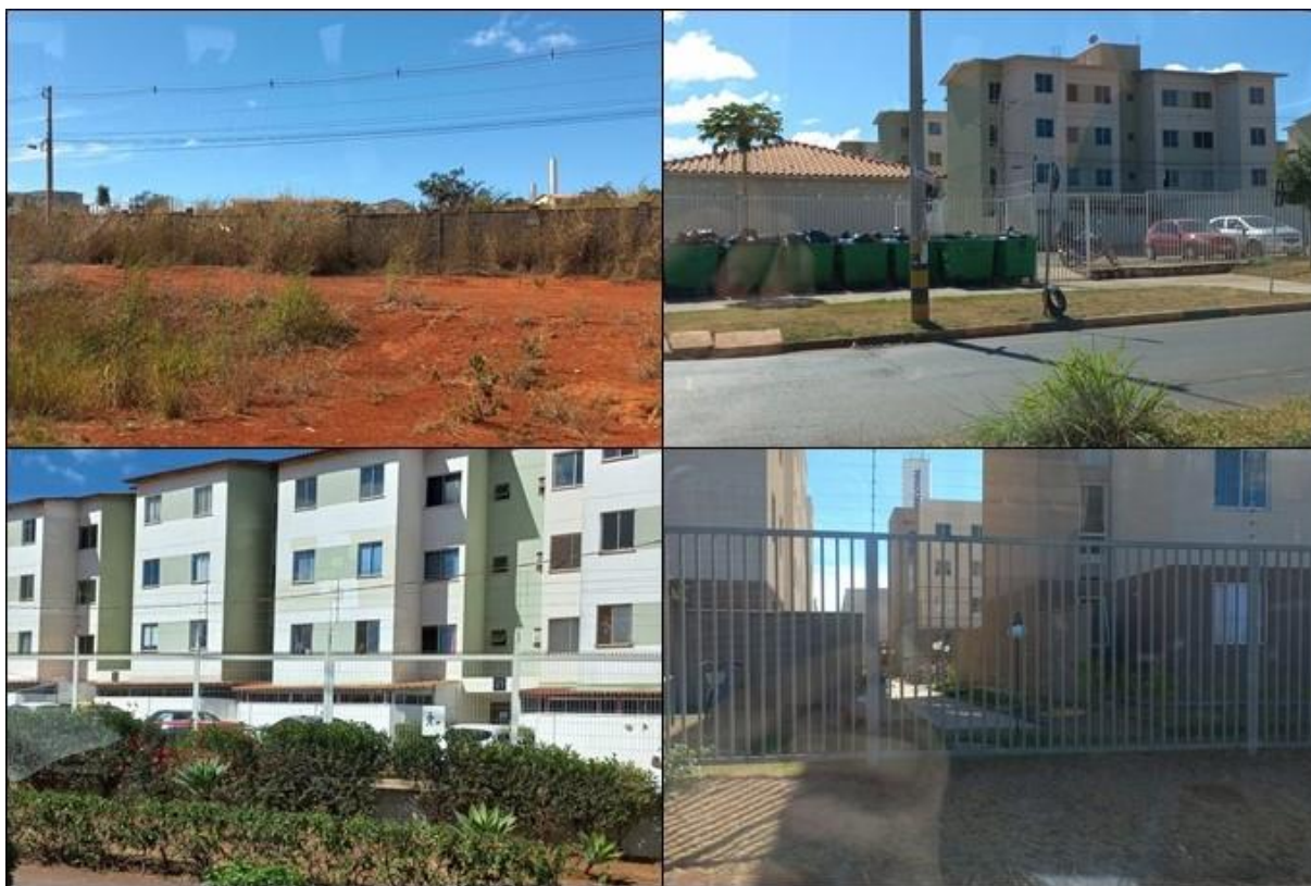
Figura 29: Fotos da visita técnica ao residencial Porto Pilar
