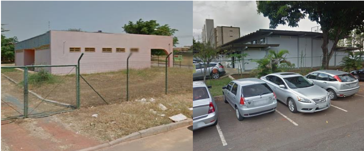
Figura 38: Relação de edifícios de Equipamentos Públicos com o espaço público. Esquerda: Unidade Básica de Saúde (UBS) Areal, Arniquireiras. Direita: Centro de Saúde (CS) 09, Cruzeiro.
