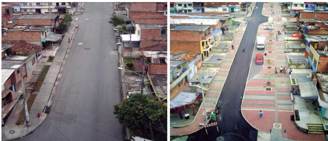
Figura 27: Antes x Depois da Calle 107 – exemplo de qualificação de calçadas com estacionamento ao longo da via e estreitamento de faixas, Medellín (Colômbia)
