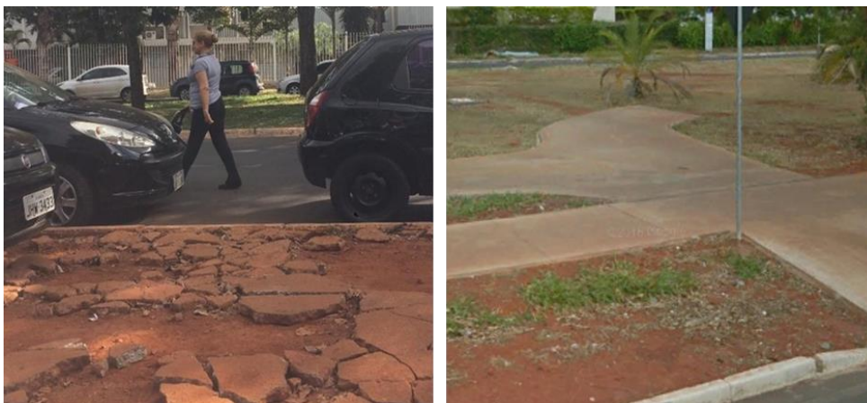
Figura 36: Esquerda: calçada em péssimo estado de conservação no SRTVS, Brasília. Direita: ciclovia descontinuada, Sudoeste.
