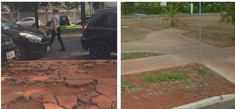
Figura 71: Esquerda: calçada em péssimo estado de conservação no SRTVS, Brasília. Direita: ciclovia descontinuada, Sudoeste.
