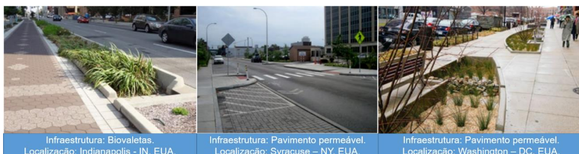
Figura 89: Exemplo de infraestrutura verde de drenagem urbana para as Vias de Circulação ou Vias de Atividades
