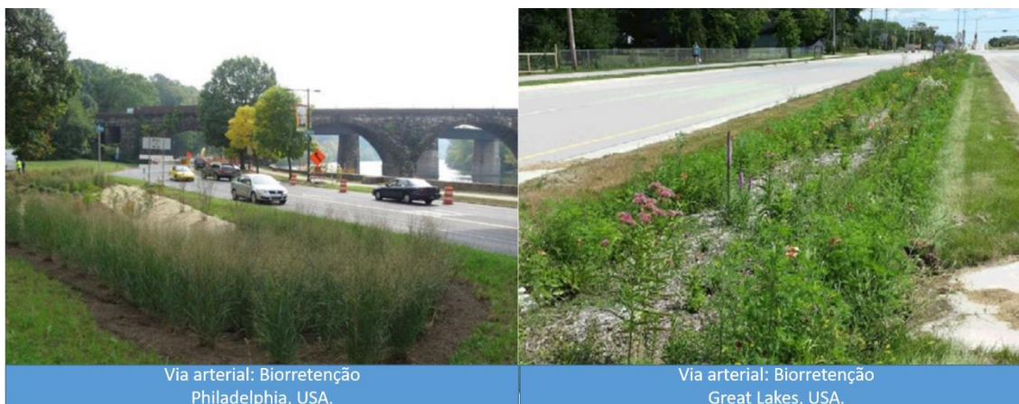
Figura 86: Exemplo de infraestrutura verde de drenagem urbana para as Vias de Circulação ou Vias de Atividades
