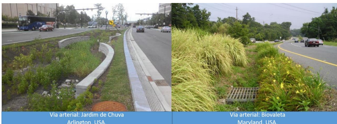
Figura 87: Exemplo de infraestrutura verde de drenagem urbana para as Vias de Circulação ou Vias de Atividades
