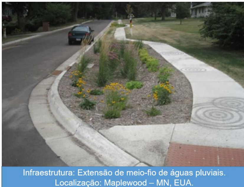
Figura 91: Exemplo de infraestrutura verde de drenagem urbana para Vias de Circulação de Vizinhança, Vias Parque e vias locais Fonte: Green Streets Handbook , 2021.
