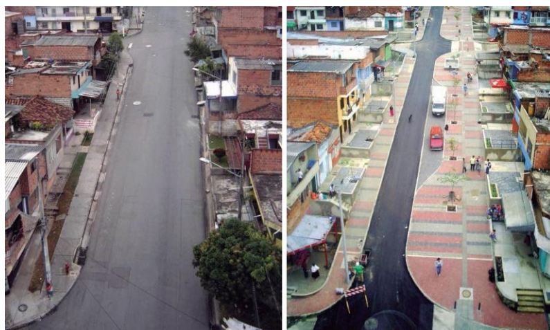
Figura 62: Antes x Depois da Calle 107 – exemplo de qualificação de calçadas com estacionamento ao longo da via e estreitamento de faixas, Medellín (Colômbia)
