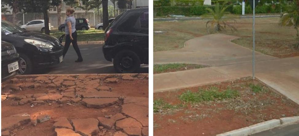
**Figura 36:** Esquerda: calçada em péssimo estado de conservação no SRTVS, Brasília. Direita: ciclovia descontinuada, Sudoeste.
