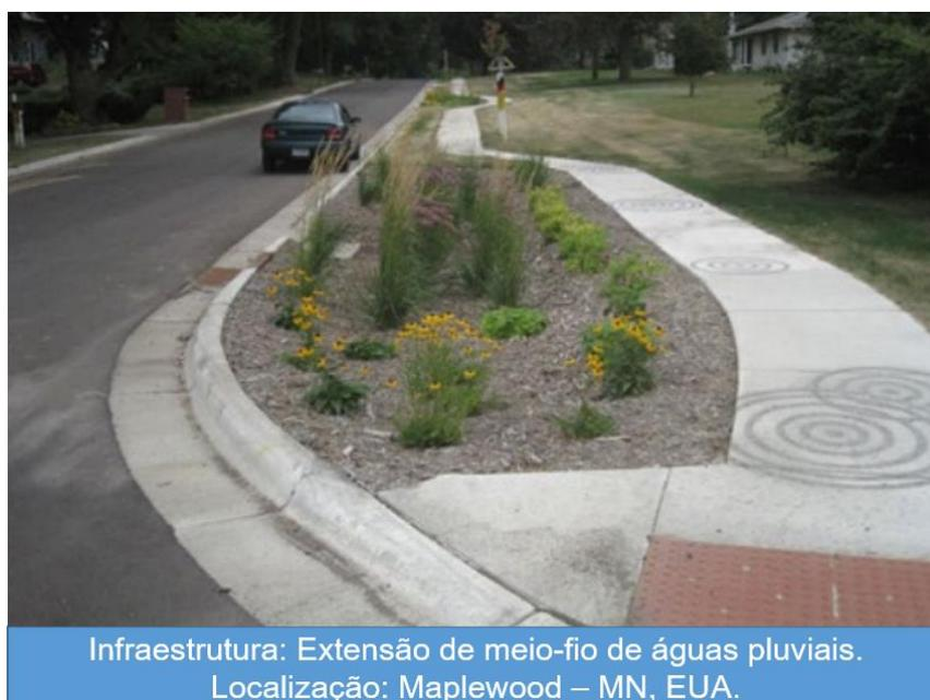
Infraestrutura: Extensão de meio-fio de águas pluviais.
