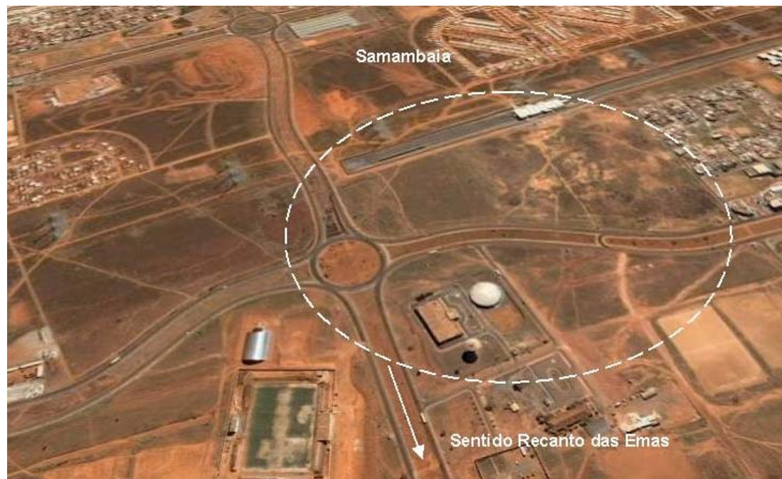
FIGURA 110 – PÓLO MULTIFUNCIONAL SAMAMBAIA
